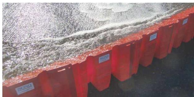
Auf diese Weise lässt sich der Boxwall zur kontrollierten Ableitung von Wassermassen durch Straßen einsetzen, was die Situation stromaufwärts entlastet. Will man das Wasser zur Seite hin ableiten, baut man einen diagonalen Wall. In welchem Winkel zur Strömungsrichtung der Wall aufgestellt wird, hängt von der Menge und Geschwindigkeit des Wassers ab.
